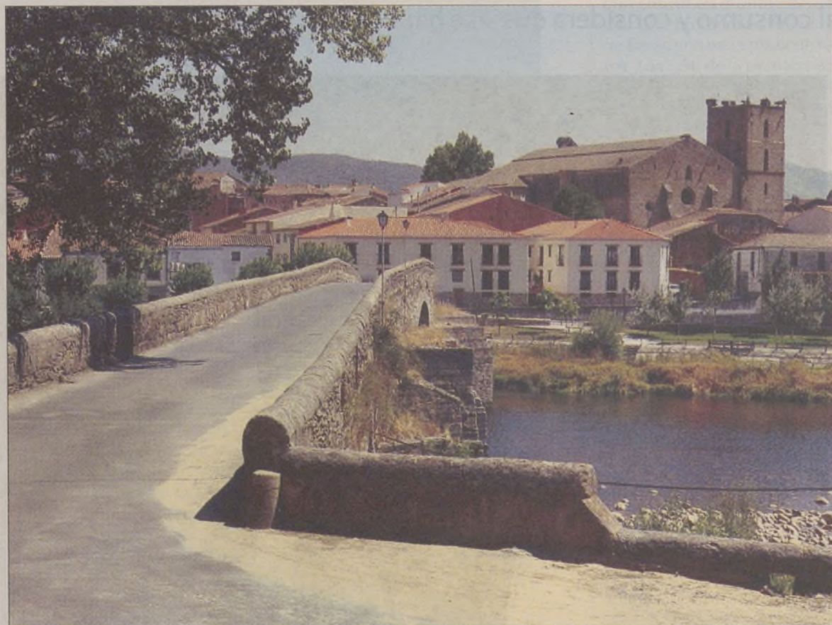
Imagen de la iglesia de la Asunción de Nuestra Señora, con el puente románico sobre el río Tormes en primer término.
