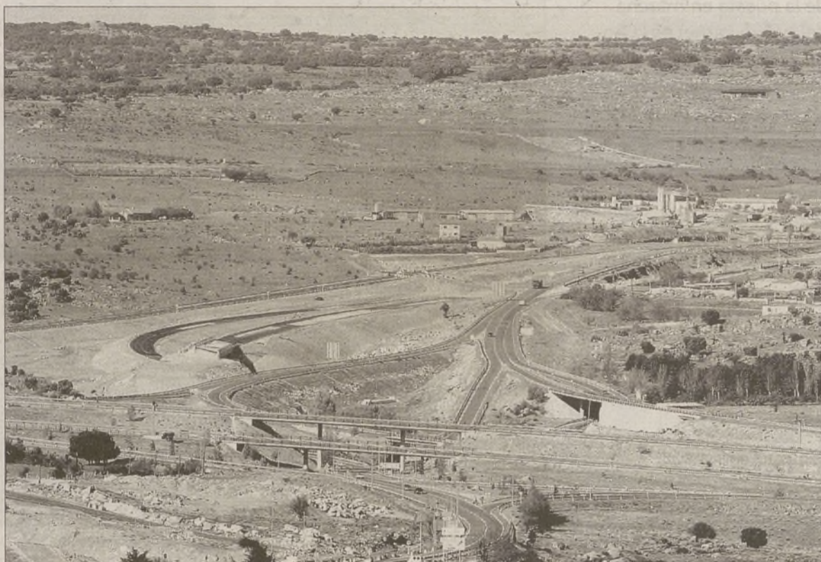
Aspecto de las obras de la A-50, en su tramo de conexión con la circunvalación de Ávila. /DAVID CASTRO
