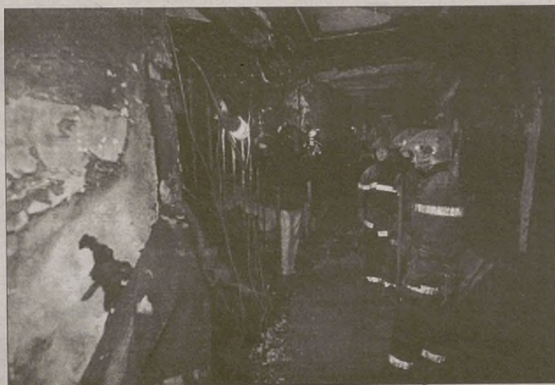
Estado en el que quedó el interior del edificio de apartamentos.
