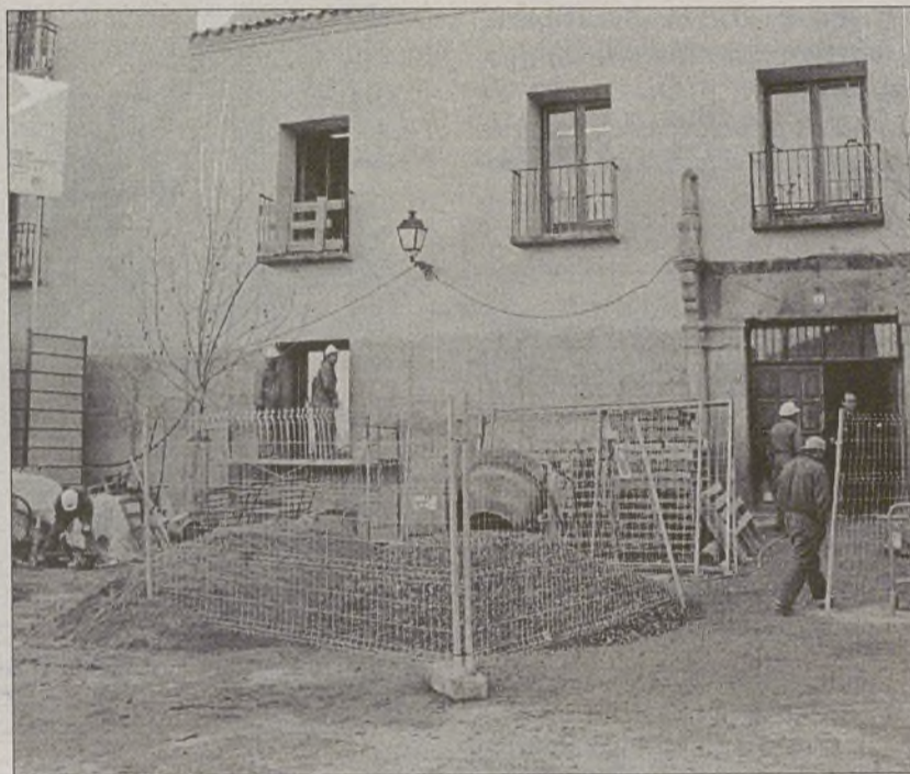
Las obras del edificio Padilla están prácticamente terminadas. M.SOTO
