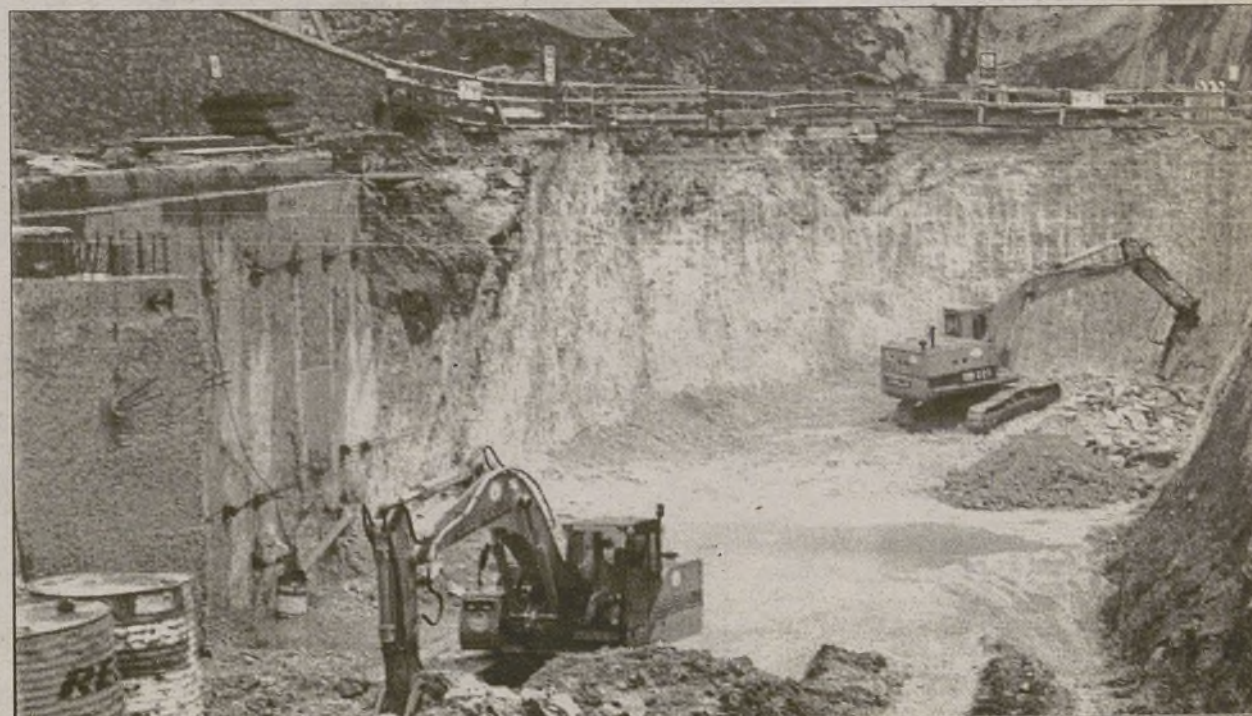
Imagen de las obras del aparcamiento del Huécar.
