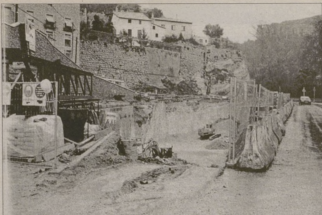
El aparcamiento de la Hoz del Huécar ya se encuentra en construcción.
