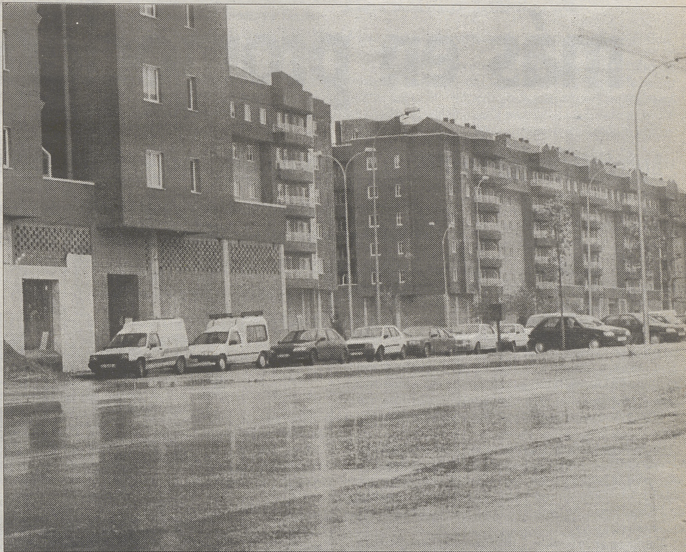
La prioridad de la Diputación son las obras de abastecimiento e infraestructuras de aguas.
