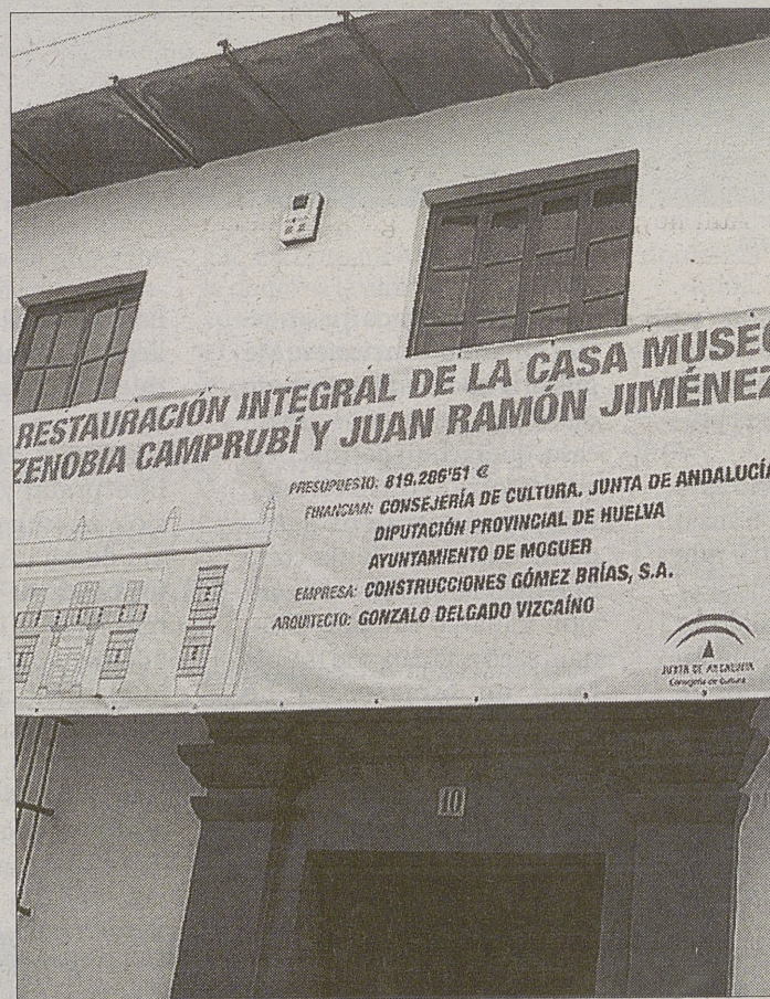
Los operarios están por culminar la obra de restauración
