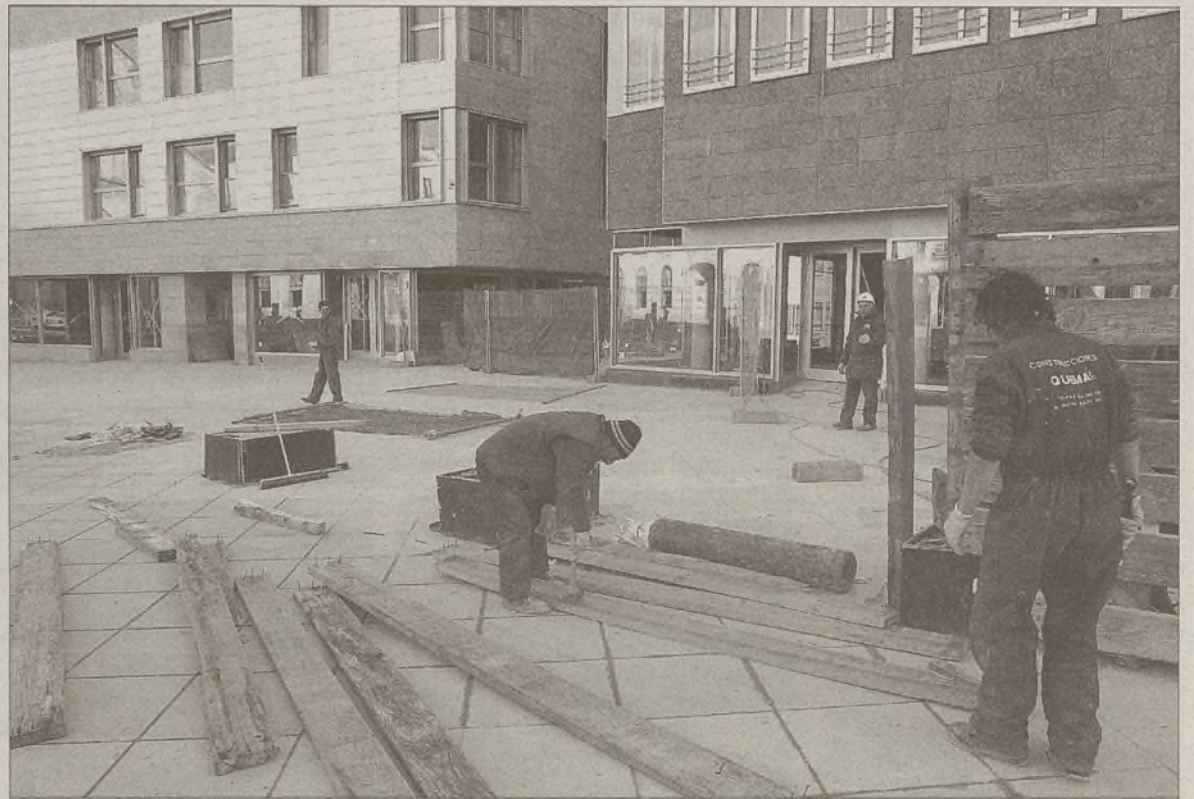
Los obreros retiran las vallas que rodean al edificio de la zona sur de El Grande. /PABLO REQUEJO
