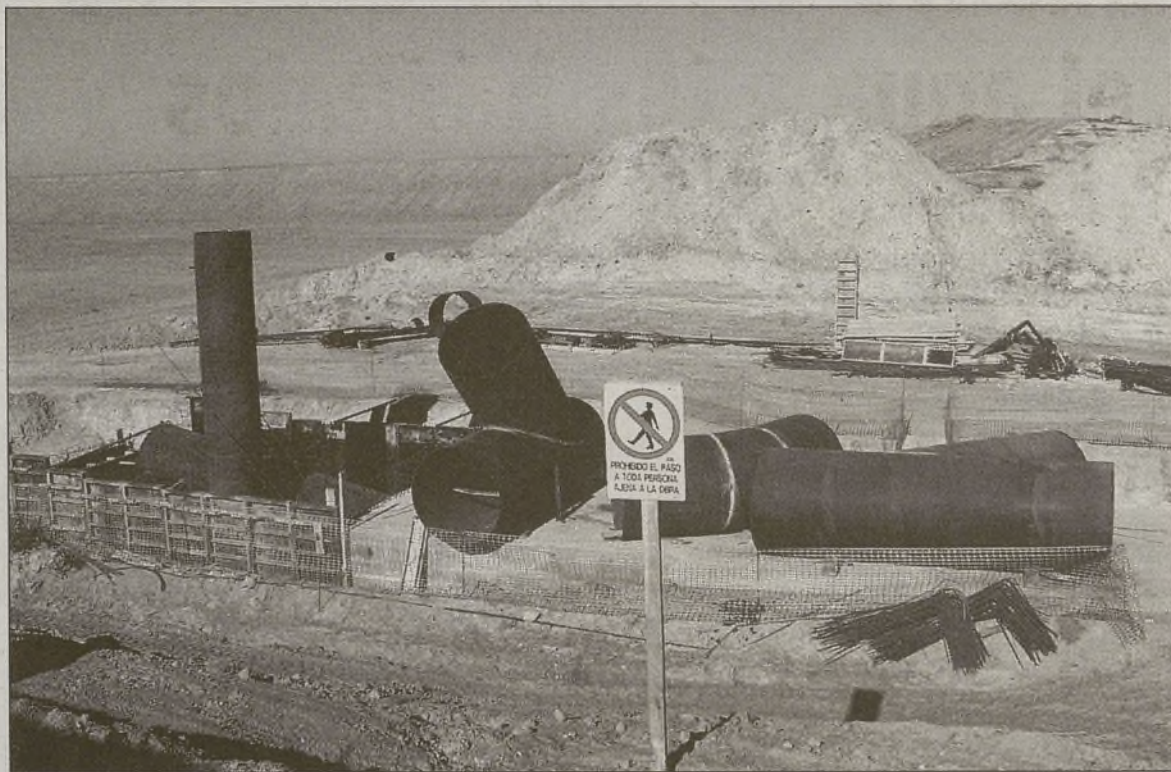
Obras del regadío de Las Cogotas en Nava de Arévalo. / M. M. E.
