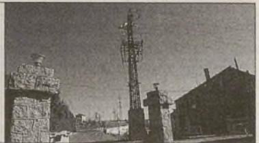
Torre de alta tensión que será retirada en los próximos días.
