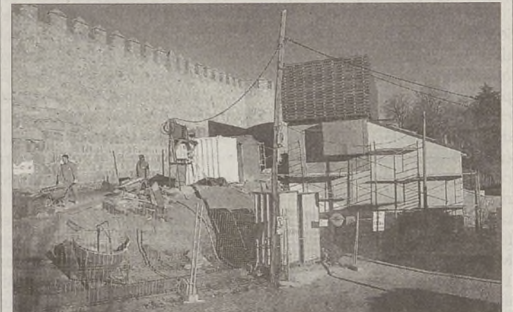
Obras del futuro Centro del Misticismo. / ENRIQUE LUIS
