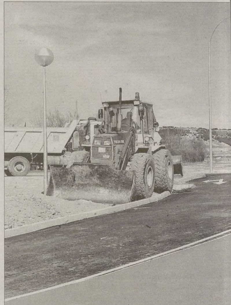
Una máquina trabaja en la urbanización de una futura área residencial. / E.C.
