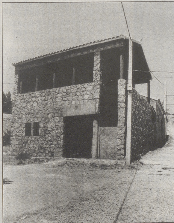
Estado de las obras del Centro Polivalente.
