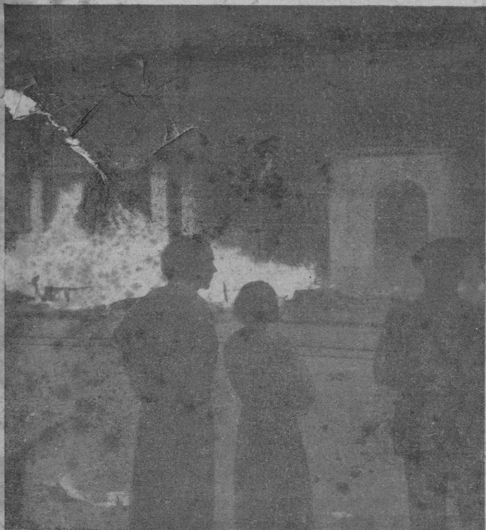
Afán de destrucción. — En Málaga como en todas las provincias donde dominan los rojos, se suceden los incendios en edificios y monumentos. He aquí una muestra.
