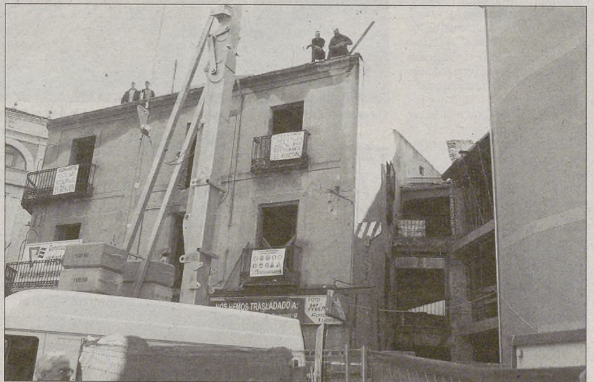
Edificio de la Plaza de Zurraquín, que albergará un nuevo hostel en pleno centro de la ciudad. Enrique
