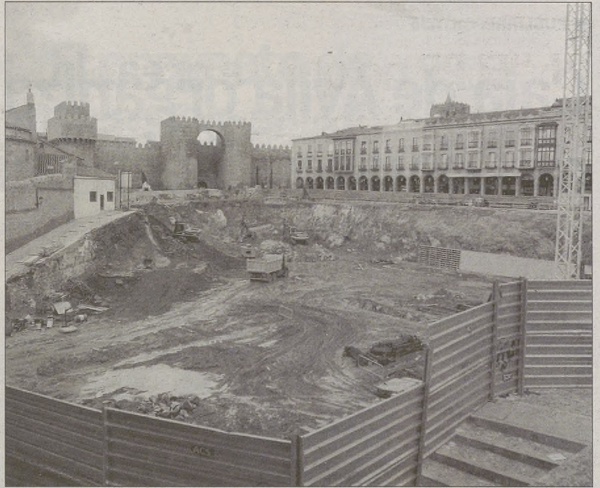
Las obras en El Grande avanzan según los plazos previstos.
