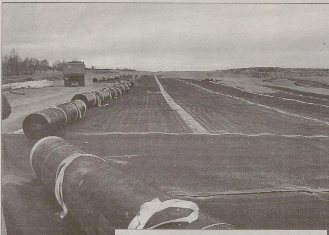
Rollos de polietileno que se extienden sobre el viejo vertedero, y conducciones para controlar el gas que producen los residuos / ENRIQUE
