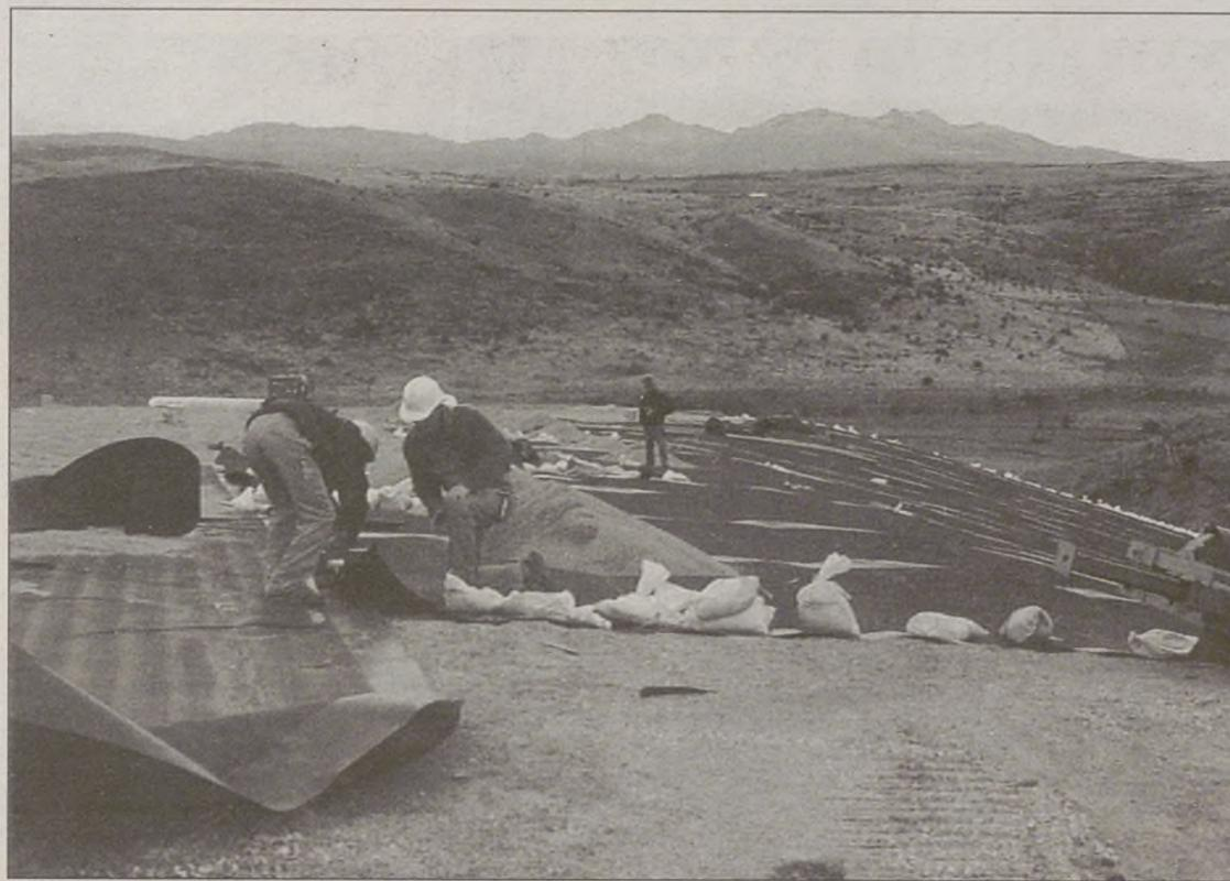
Trabajos de soldado de los rollos de polietileno para impermeabilizar la superficie / ENRIQUE
