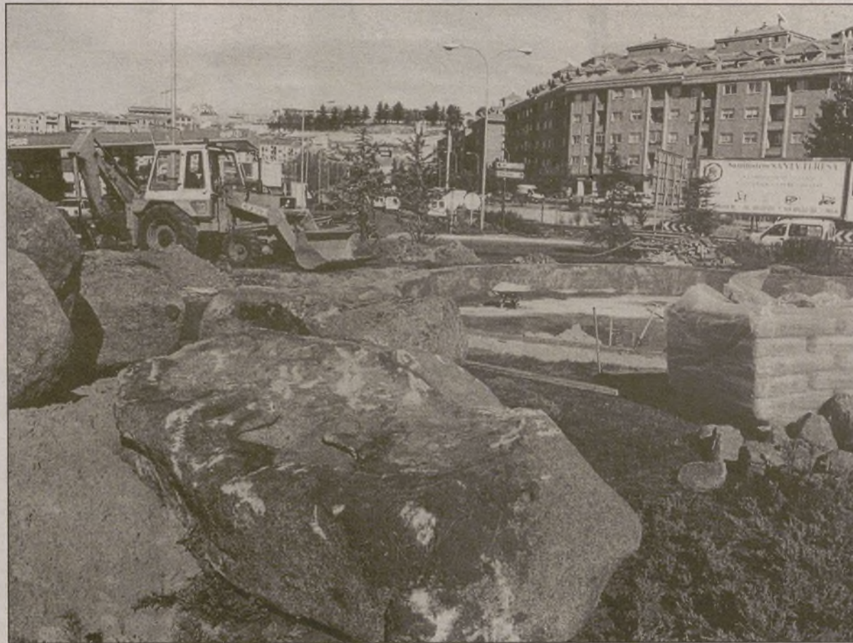
Obras de construcción del estanque donde se ubicará la estatua / LUMBRERAS
