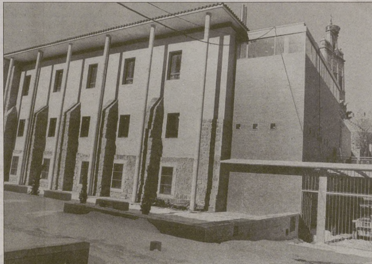
El edificio del Archivo Histórico Provincial está prácticamente finalizado / ENRIQUE
