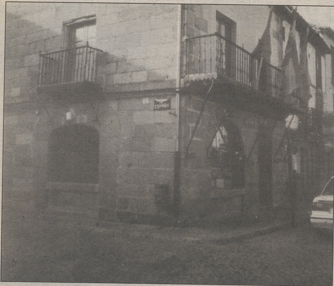
Vista del Ayuntamiento de El Barco de Ávila
