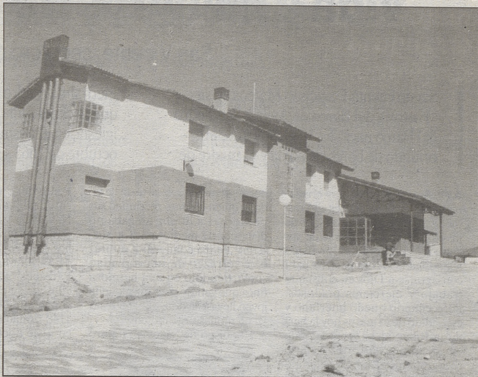
Edificio de ASESCA en la etapa de su construcción
