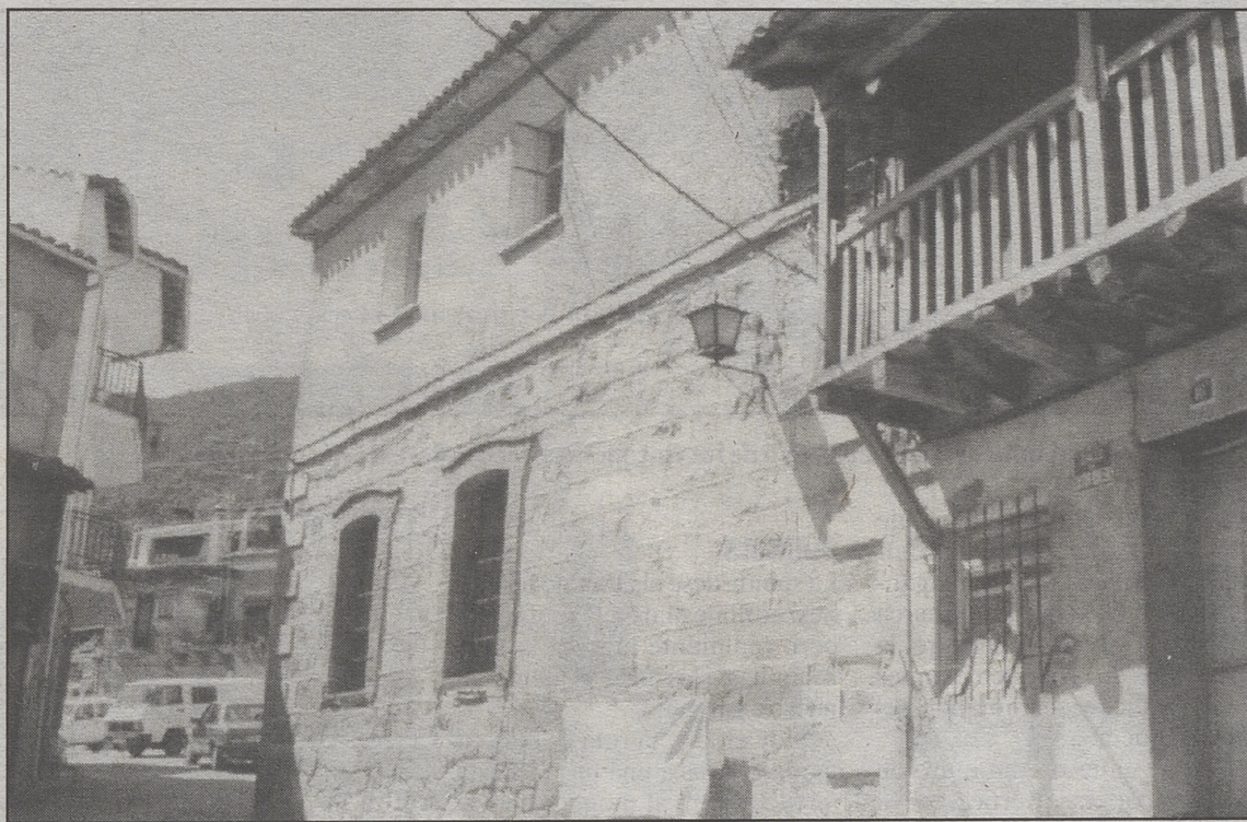
Edificio que rehabilitarán los alumnos de la Escuela Taller, entre la Plaza y la calle Castor Robledo.
