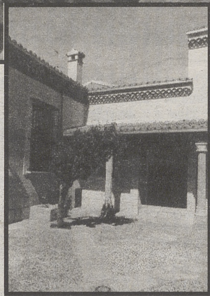
Segundo patio de la Cámara. LUMBREAS
