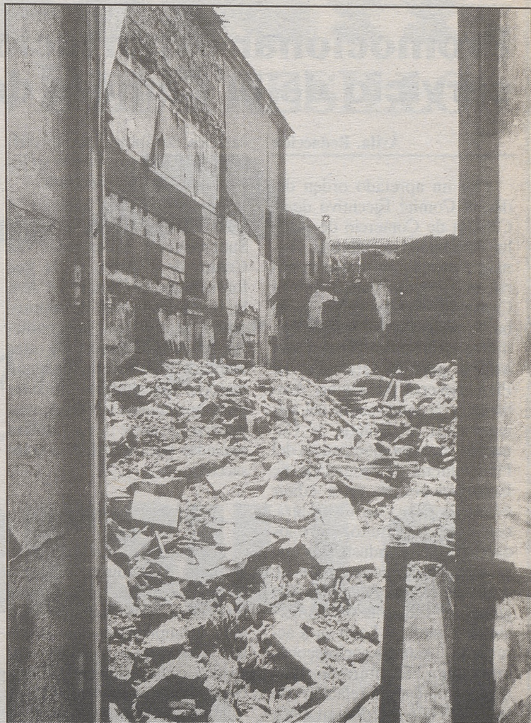
Estado en el que se encontraban las obras de rehabilitación del Teatro Principal hace ahora exactamente una semana. LUMBRERAS
