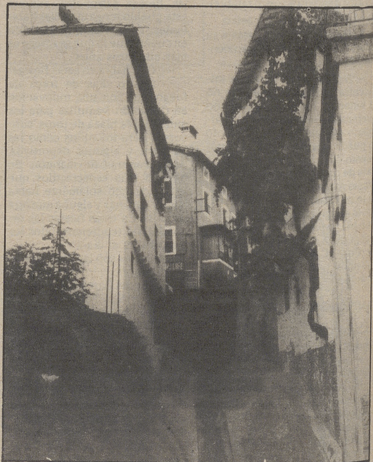
La construcción en Guisando se ha quedado prácticamente paralizada.
