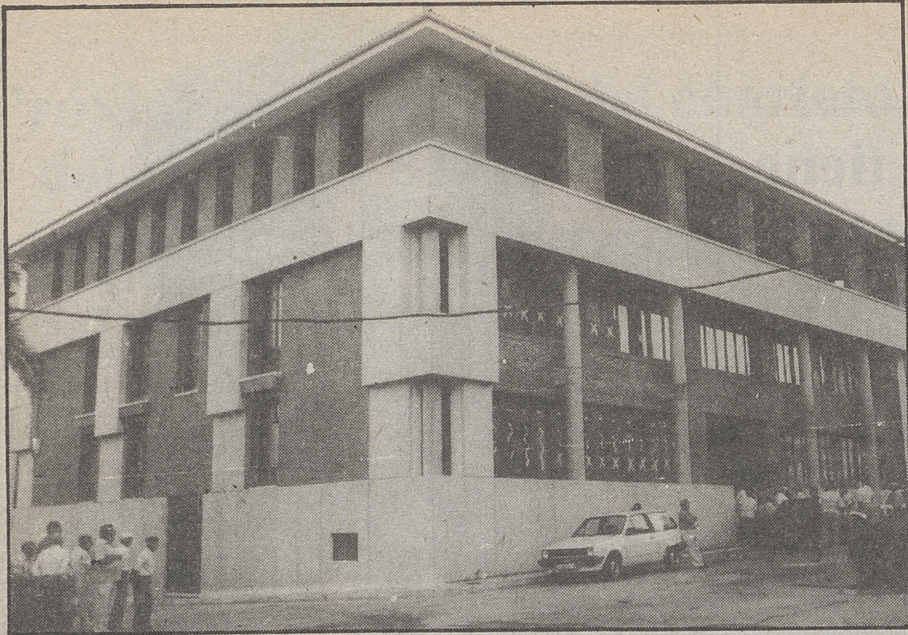
Edificio del nuevo Centro de la Tercera Edad.
