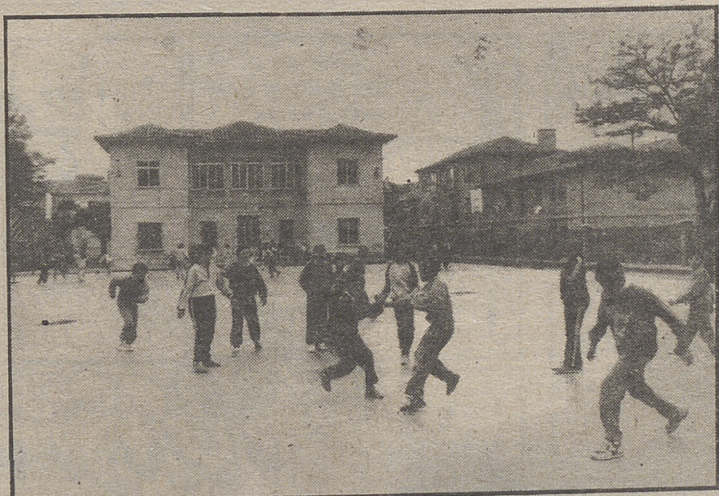
El patio y la entrada del centro necesitan ser arreglados
