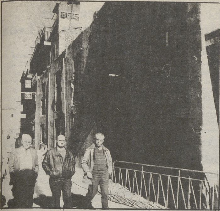
Las labores de derribo ocuparon buena parte de la calle Estrada LUMBRERAS
