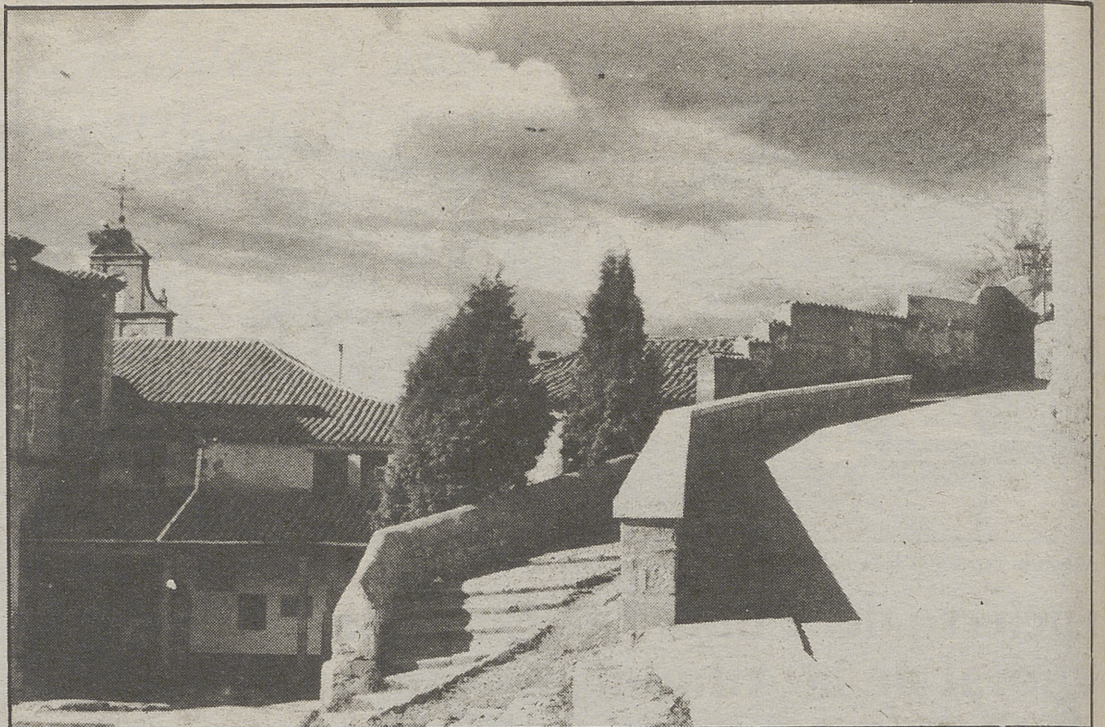
La pavimentación en Nuestra Señora de Sonsoles ha terminado LUMBRERAS
