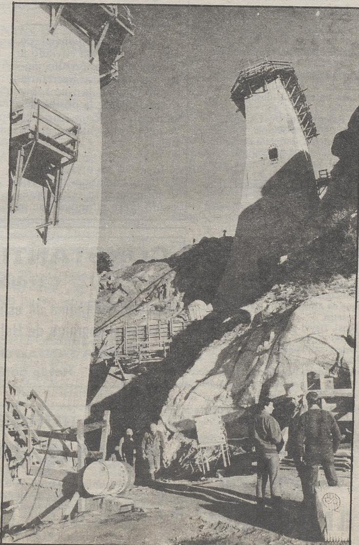
Estado actual de las obras de la presa. El muro queda interrumpido en el lugar de la falla
