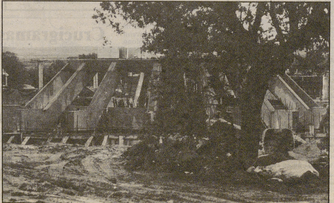
La obra civil de la potabilizadora, muy avanzada.
