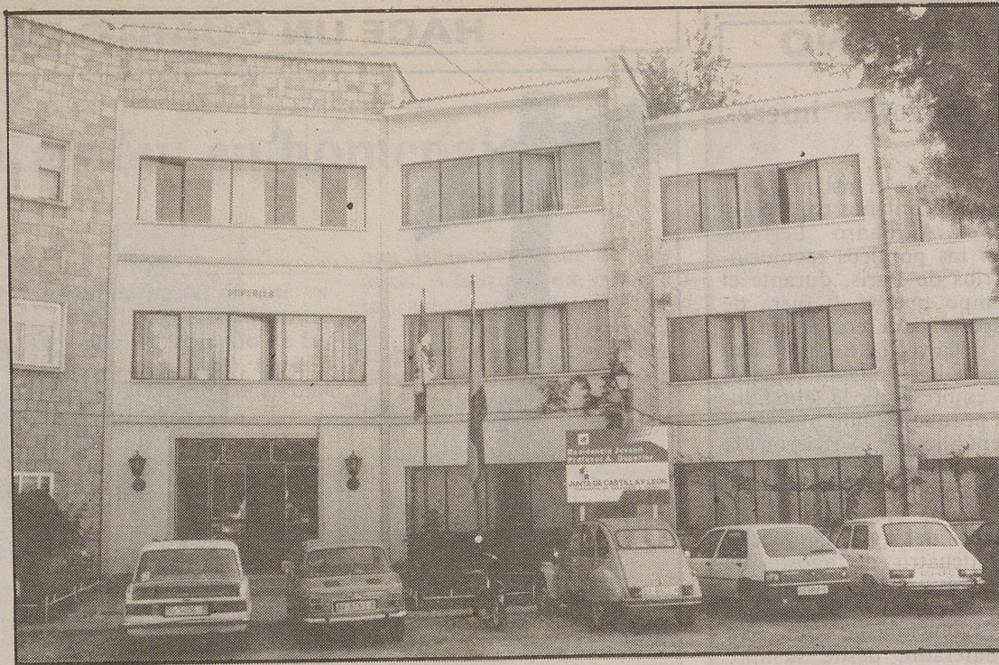
Edificio principal de la Residencia Arturo Duperier.
