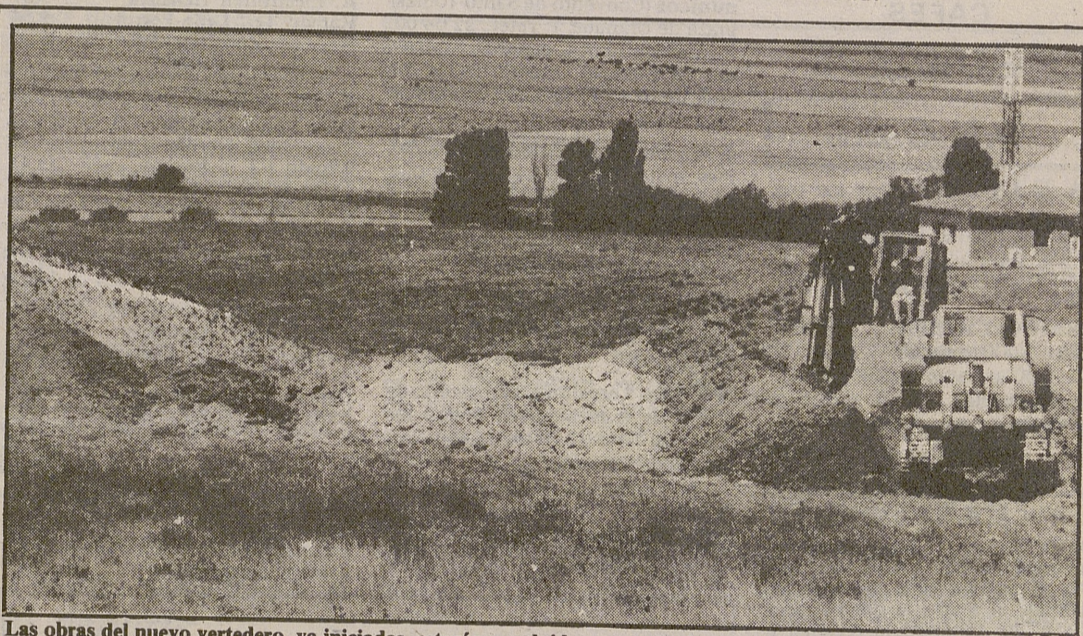
Las obras del nuevo vertedero, ya iniciadas, estarán concluidas en el próximo otoño.
