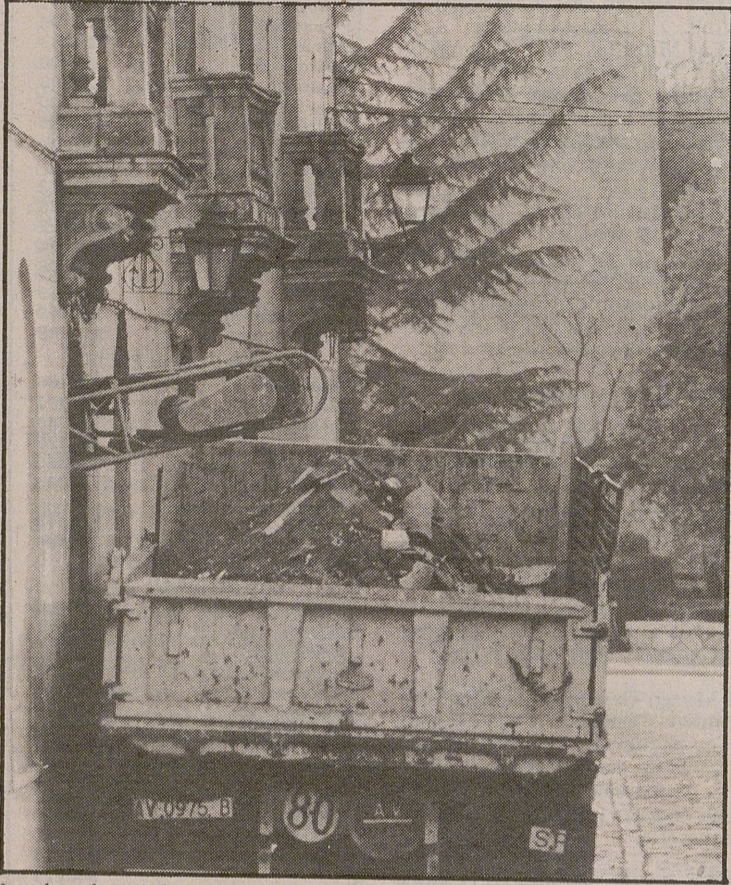
Las obras de vaciado previas a la transformación del Teatro Principal se han iniciado. LUMBRERAS
