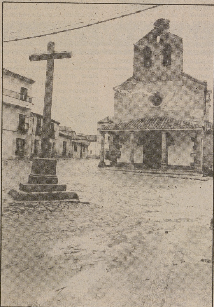
A la Plaza de Las Vacas parece haberle tocado ya el turno de las obras. LUMBRERAS
