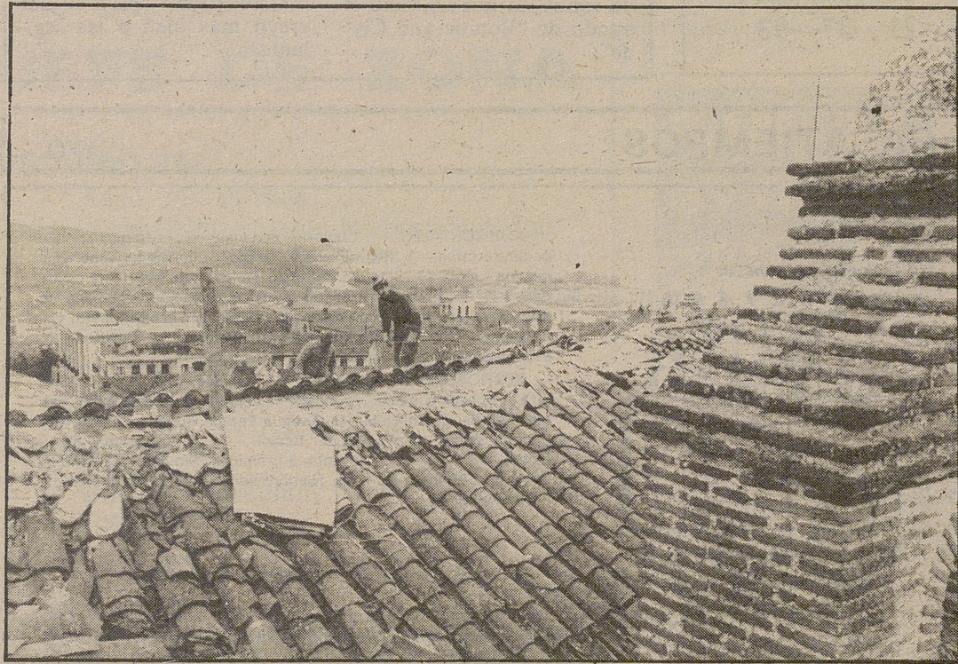
También se repone la madera que se encuentra en mal estado.
