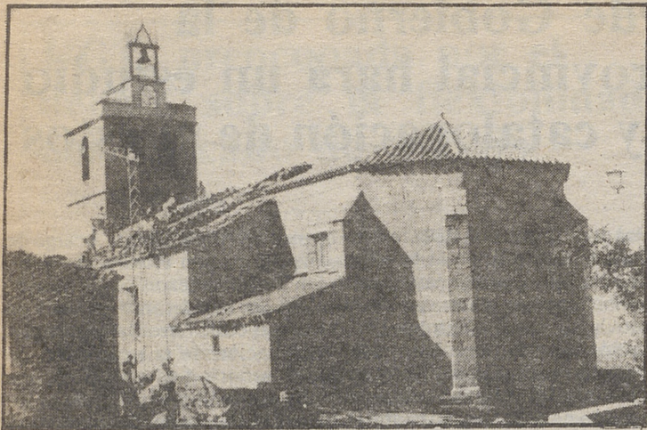
Iglesia parroquial de Diego Alvaro en Obras
