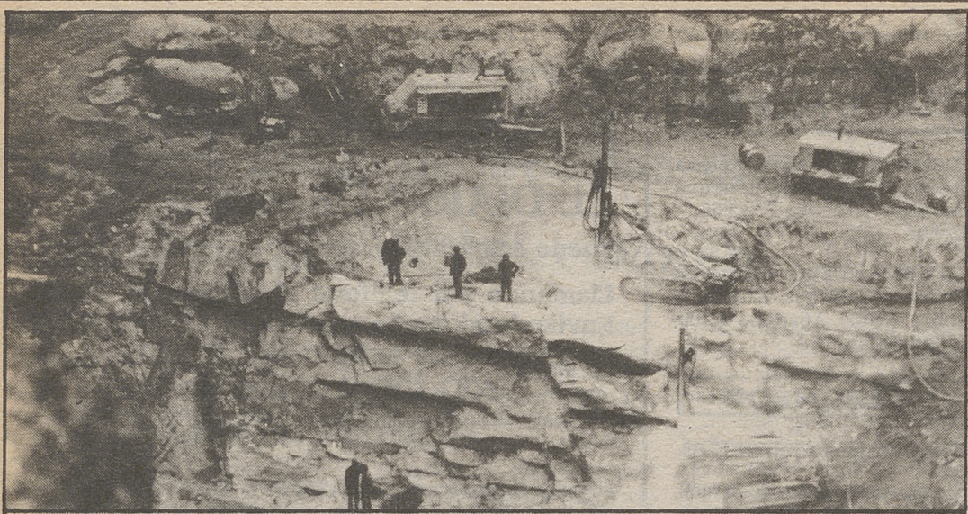
El muro se construirá apoyado en las rocosas laderas de dos cerros
