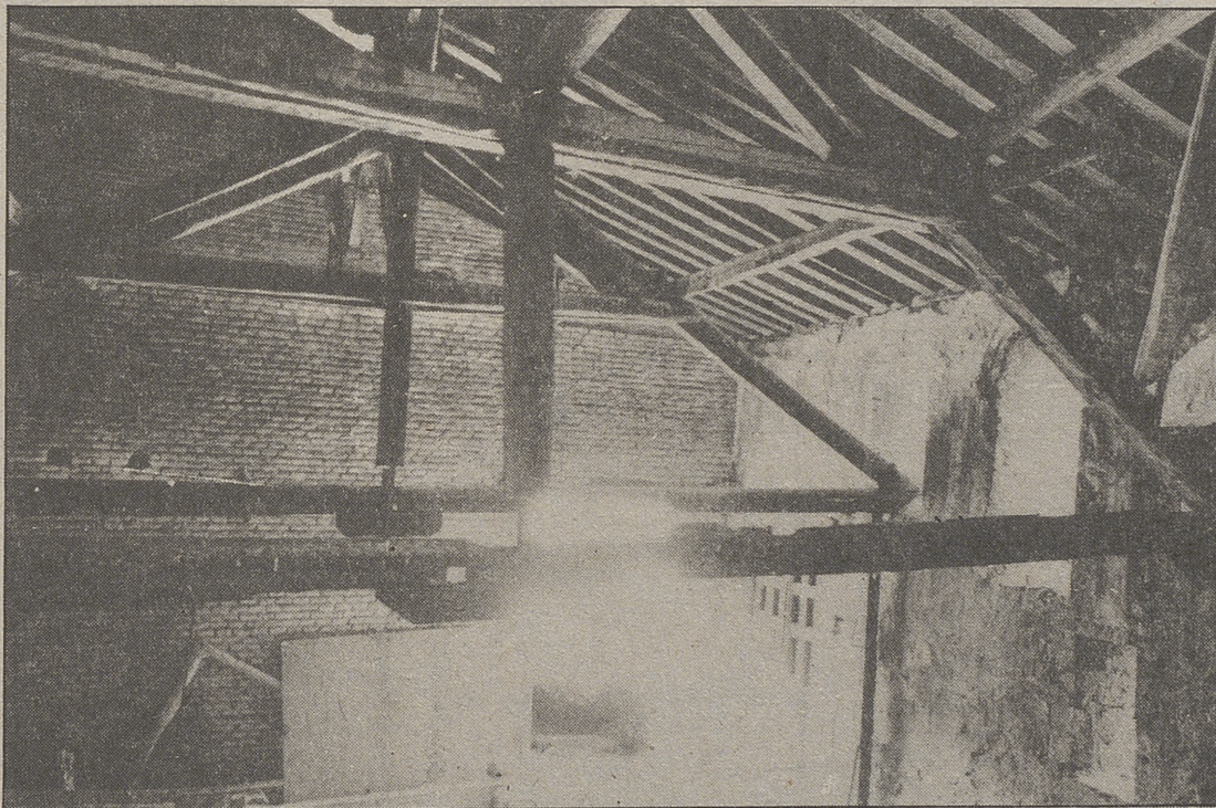
Interior del Episcopio, cuya restauración se está llevando a cabo
