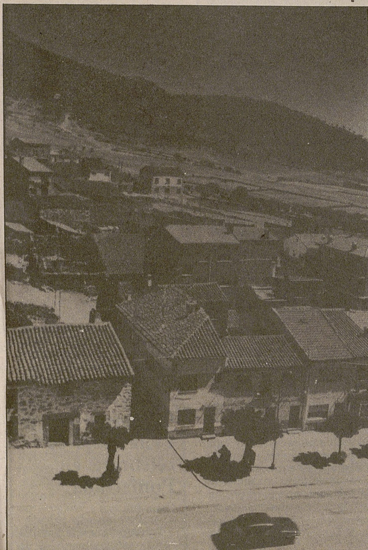
Las calles necesitan ser pavimentadas
