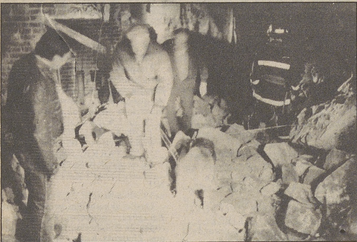
Los primeros trabajos consistieron en asegurarse de que nadie había bajo las piedras LUMBRERAS
