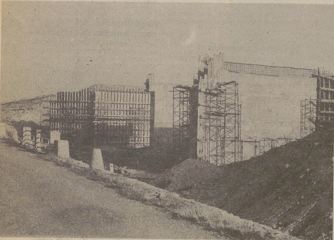
La fotografía muestra el estado actual de las obras de construcción del puente para la variante de la carretera de El Espinar, que discurrirá en ese lugar a una altura muy superior a la actual, ya que el agua embalsada en la presa del Voltoya cubrirá un trozo de la actual carretera.
