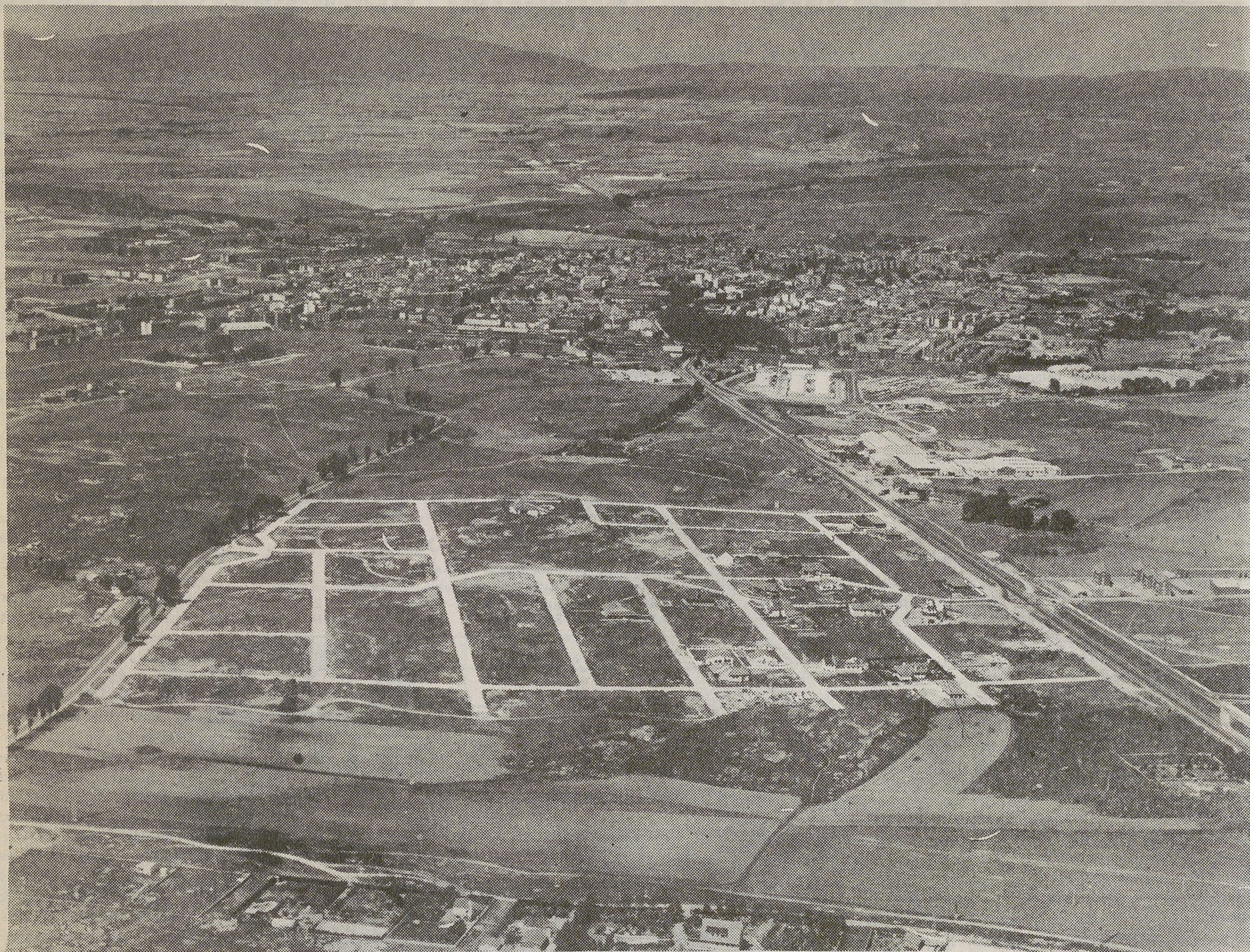
Vista aérea de Las Hervencias. (2.ª fase)
