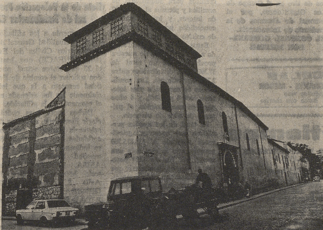
Convento de las Carmelitas de Arriba (GUADALAJARA). Evitar el «paulatino» desmantelamiento.— (Foto: C. O. A. M.).
