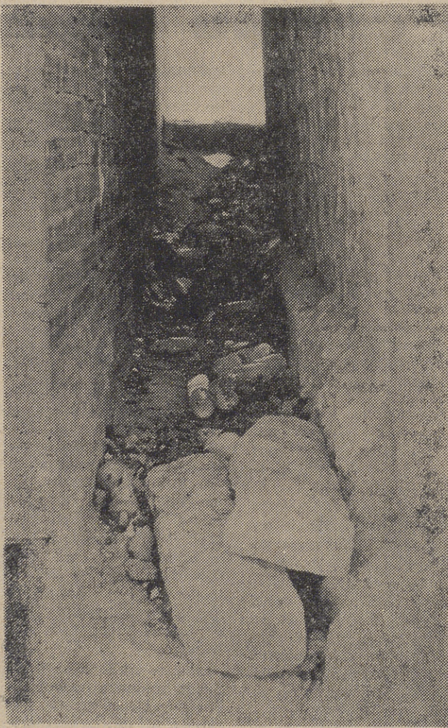
El callejón de la fotografía, que no tendrá más de medio metro de anchura, es la separación entre el moderno edificio de un restaurante y una barriada, existentes junto a la nueva carretera a Madrid por Las Navas del Marqués y Villalba, a la salida de Avila. Se trata de un espacio libre entre dos edificaciones sin ninguna utilidad que se está convirtiendo en un depósito de basuras. Es evidente que el problema no es difícil de resolver. — (Foto: LUMBRERAS).
