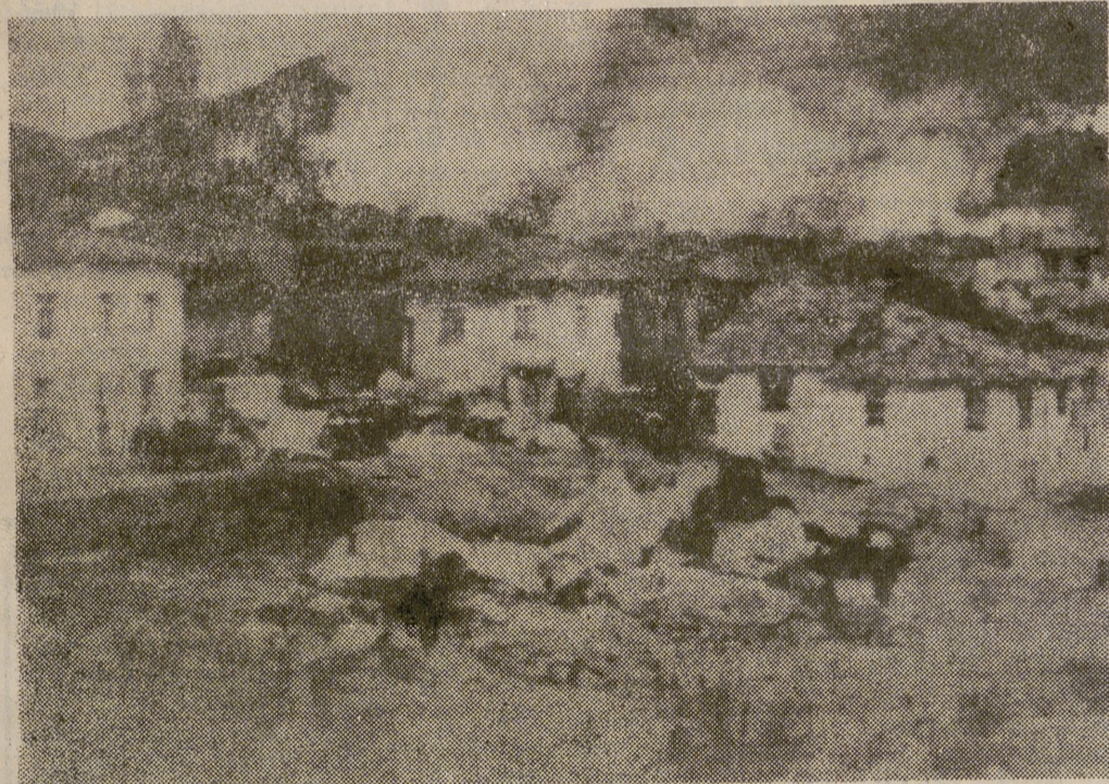
Un aspecto de la ciudad de Gediz, asolada por el terremoto.
