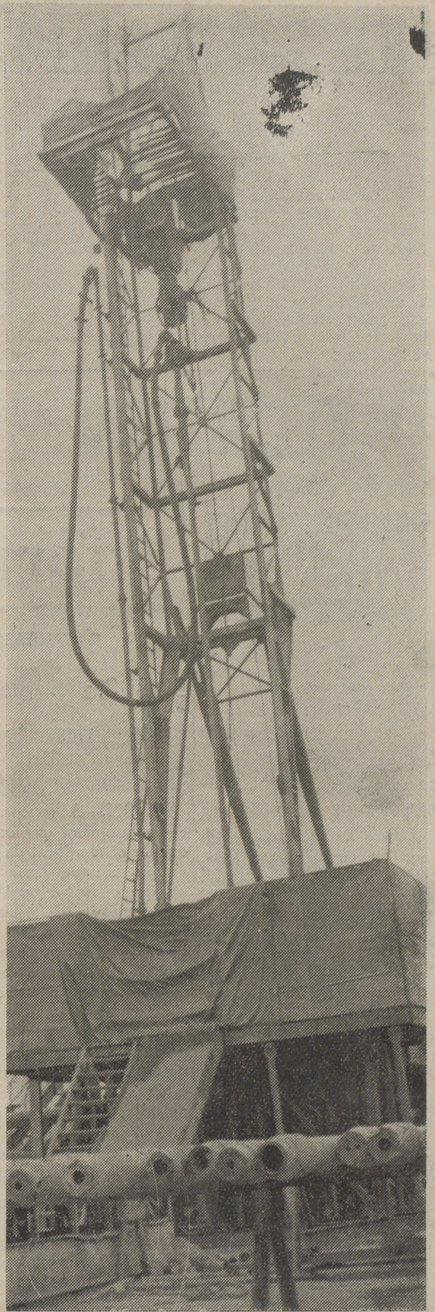
EN LA FOTOGRAFIA, LA INSTALACION DE SONDEO MONTADA EN ESCALADA, NO LEJOS DE AYOLUENGO, EN EL PARAMO BURGALÉS DE LA LORA, DONDE SE CREE EXISTE OTRO YACIMIENTO PETROLIFERO DE IGUAL O MAYOR IMPORTANCIA QUE EL DE VALDEAJOS.—(Foto “Cifra-Gráfica”).
