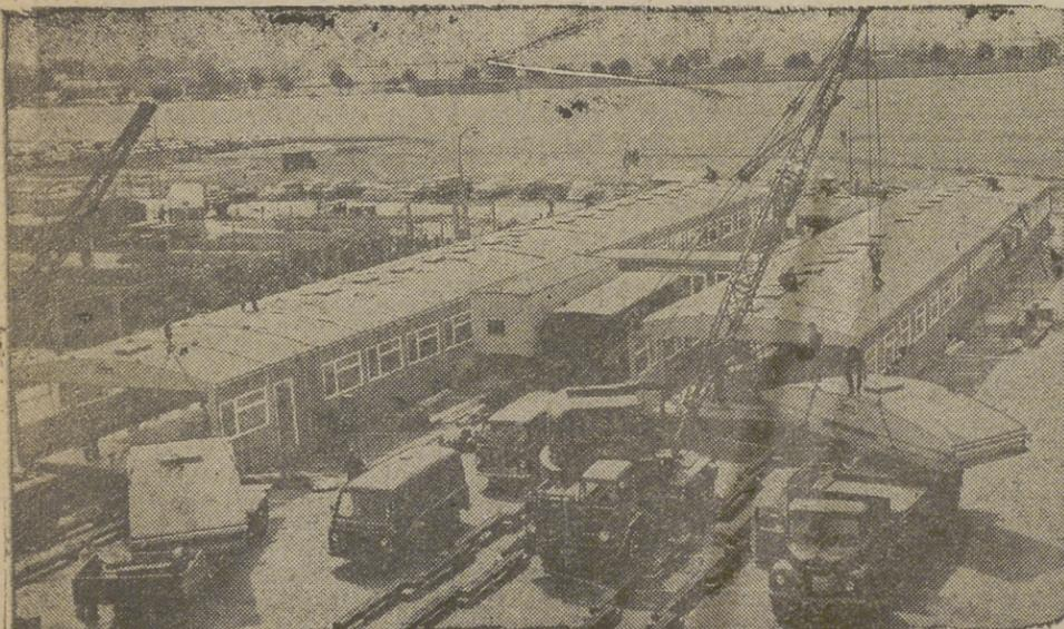
En el aeropuerto de Londres se construyó recientemente en doce horas un edificio para oficinas, que ocupa una superficie de 1.026 metros cuadrados. El edificio quedó completamente terminado, con decorado, instalaciones de agua y alumbrado y listo para ser ocupado. Sirve de alojamiento a 100 técnicos.
