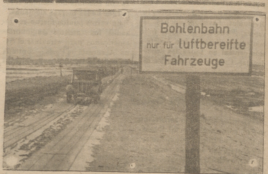
He aquí la obra gigantesca realizada por los alemanes en Rusia. Carretera de muchos kilómetros sobre zonas pantanosas rusas. Sobre ella pasan sólo coches con neumáticos. — («Presamundo»)
