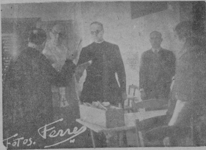
Un aspecto de la bendición de nuevo edificio
