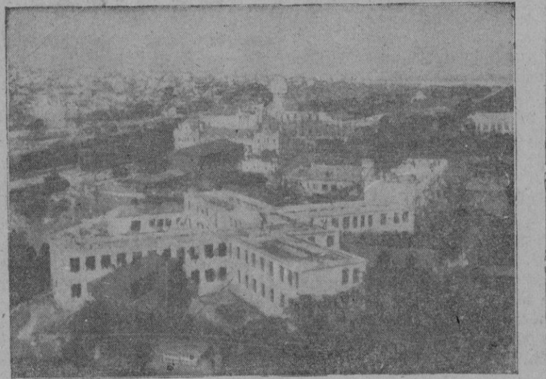
Una vista de la ciudad de Stalingrado. En primer término aparece una gran fábrica en construcción
