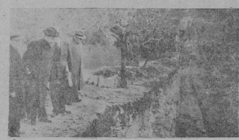
Junto a la iniciación del túnel, en "Son Vich", el Gobernador contempla las obras del ferrocarril
