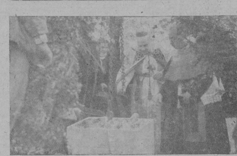
Dos detalles de la ceremonia de bendición y colocación de la primera piedra del nuevo templo.
