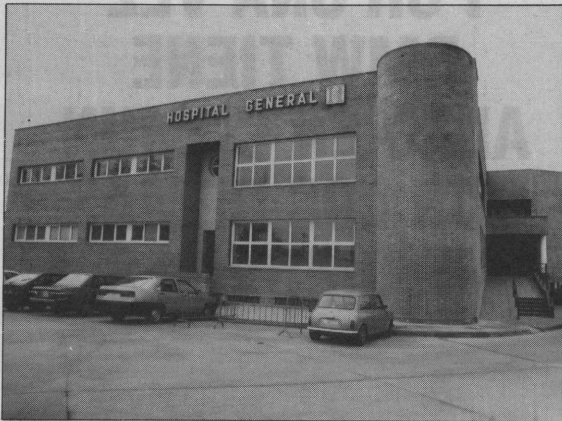
Las últimas obras en el Hospital consistieron en la creación del centro de atención especializada. PEÑALOSA
